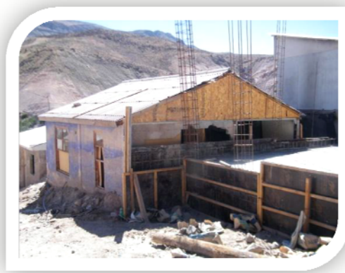
Reparación de viviendas en Camiña, región de Tarapacá.
